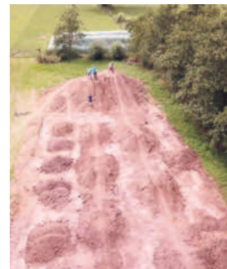
Am Sportplatz »Eggelpark« in Rösebeck gibt es eine neue Rad-Cross-Strecke.
